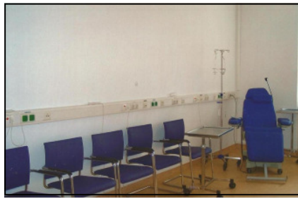
so kahl sind die Wände noch im Wartezimmer der neuen Ambulanz
